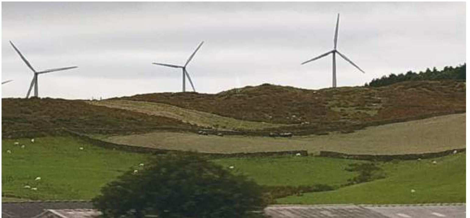
Las wind farms, granjas de viento para generar energía en Escocia
