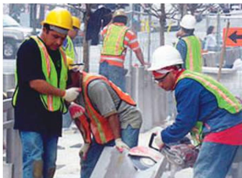
Los trabajos en sí son semejantes tanto en EE.UU. como en Ecuador.
