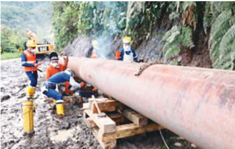
La reparación de tubos es una actividad permanente.
