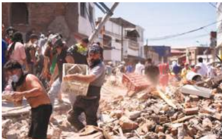
Residentes y equipos de rescate buscan entre los escombros de un edificio colapsado. Muchos tratan de salvar algo de sus bienes.
