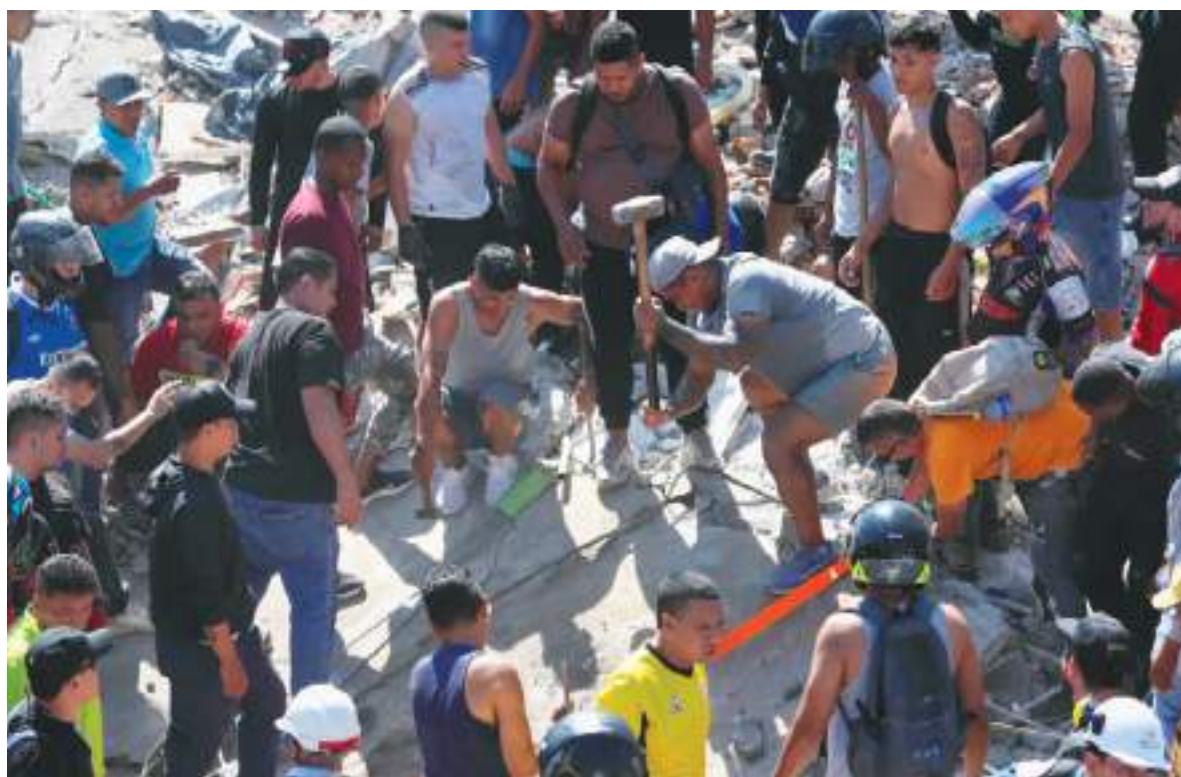
Civiles buscan entre los escombros de un edificio destruido por el terremoto en Quibdó.
